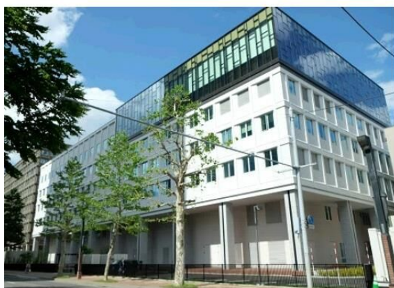
▲北海道議会庁舎 建築工事
