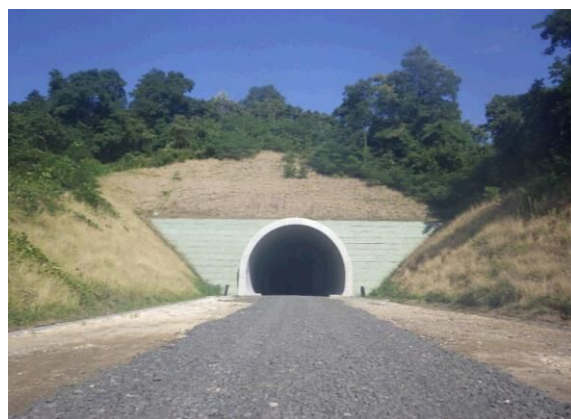
▲道道泊共和線 茅沼2号トンネル工事
